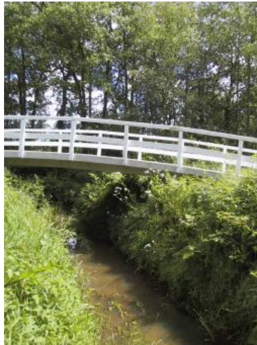
Figuur 10. Fietsbrug over de Slokkert
